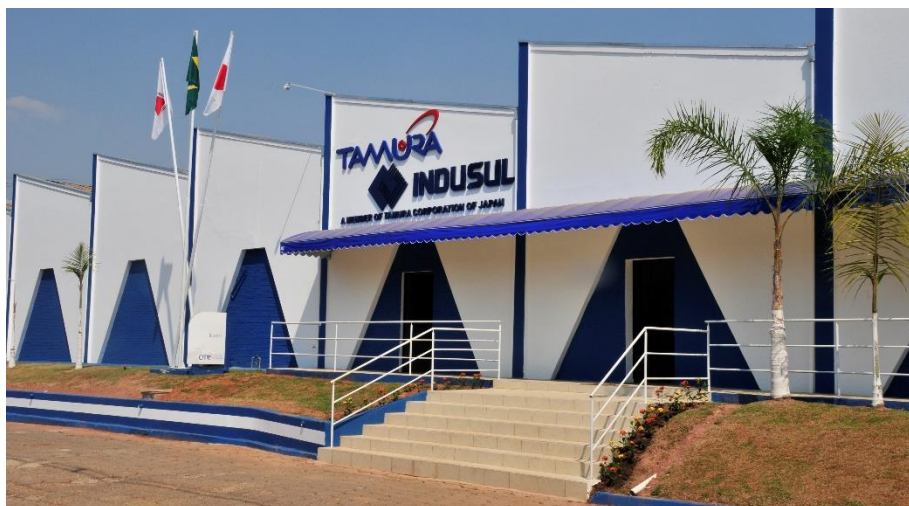
Indusul Indústria de Transformadores LTDA
